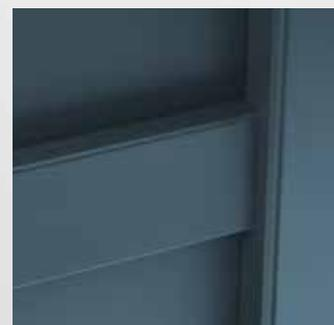
Scuro a tavole lisce esterne costituite da pannelli ad isolamento termico e struttura perimetrale interna in vista.
